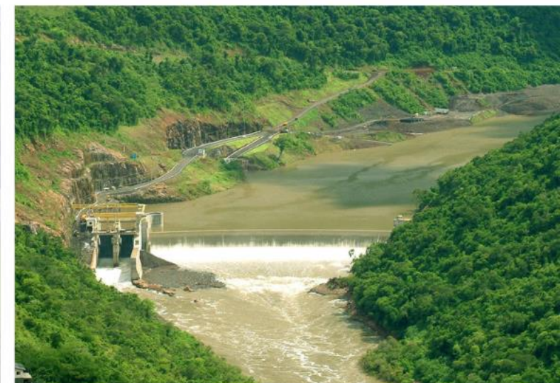
UHE Monte Claro - 130 MW
